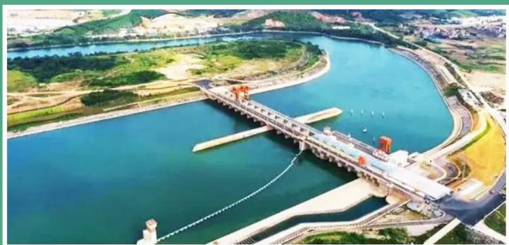
葛洲坝水利枢纽工程全貌
